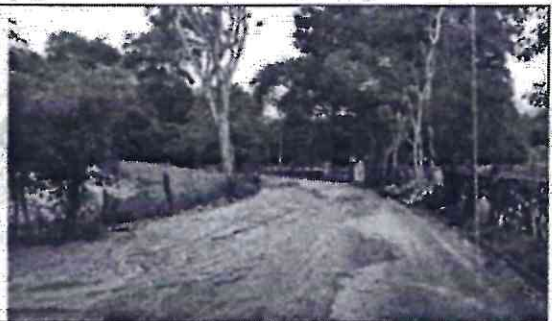
Foto 2.-Azolve en carretera, lodos
