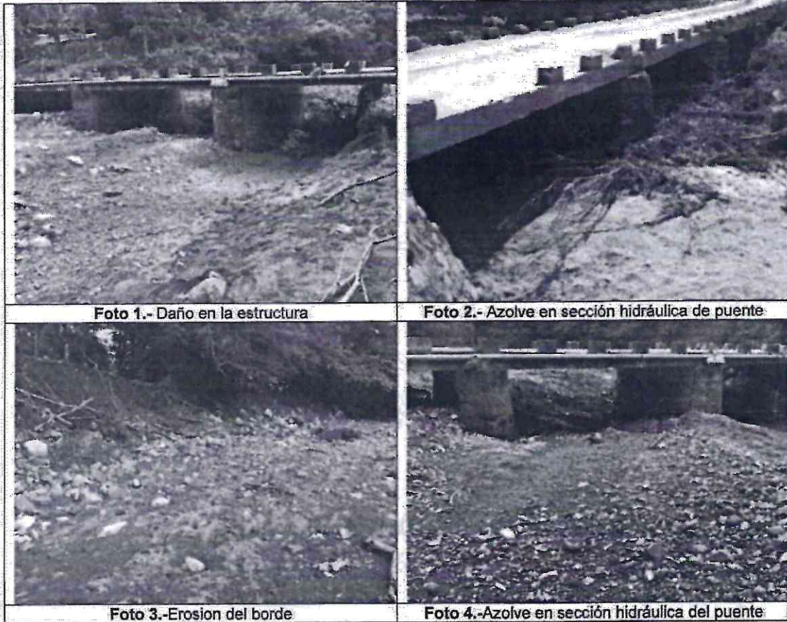
Foto 3.- Erosion del borde
